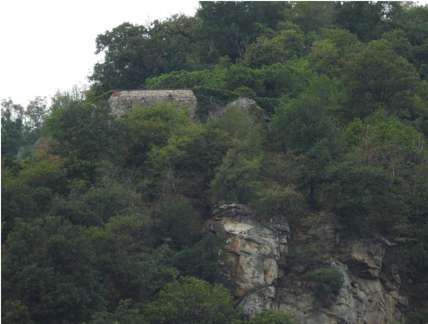
Resti di un rivellino del Forte Bramafam - Foto di Luca Grande e Simona Pons
